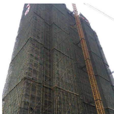
估价对象所在 33#楼整体外观
