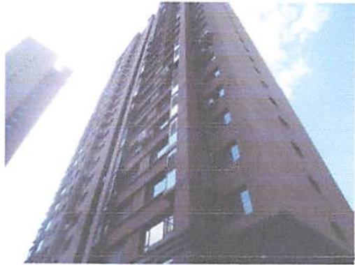
估价对象所在楼
