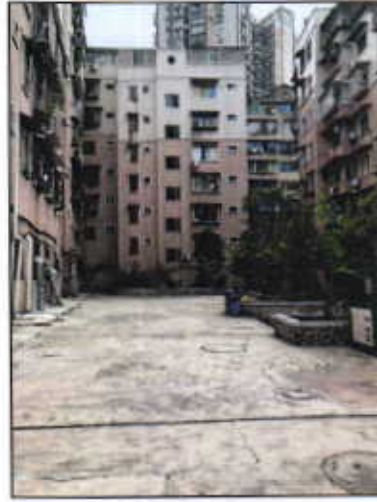
估价对象所处楼幢外观
