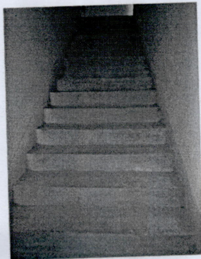
估价对象所在建筑公共楼梯
