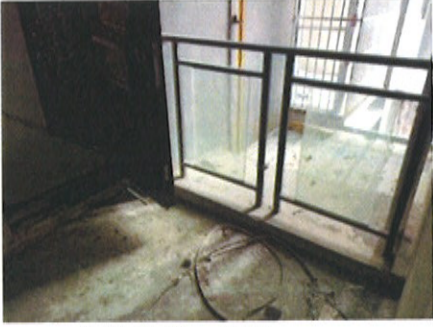
估价对象：室内
