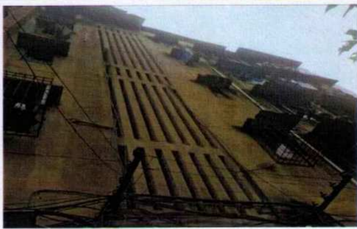
现状照片一：外观
