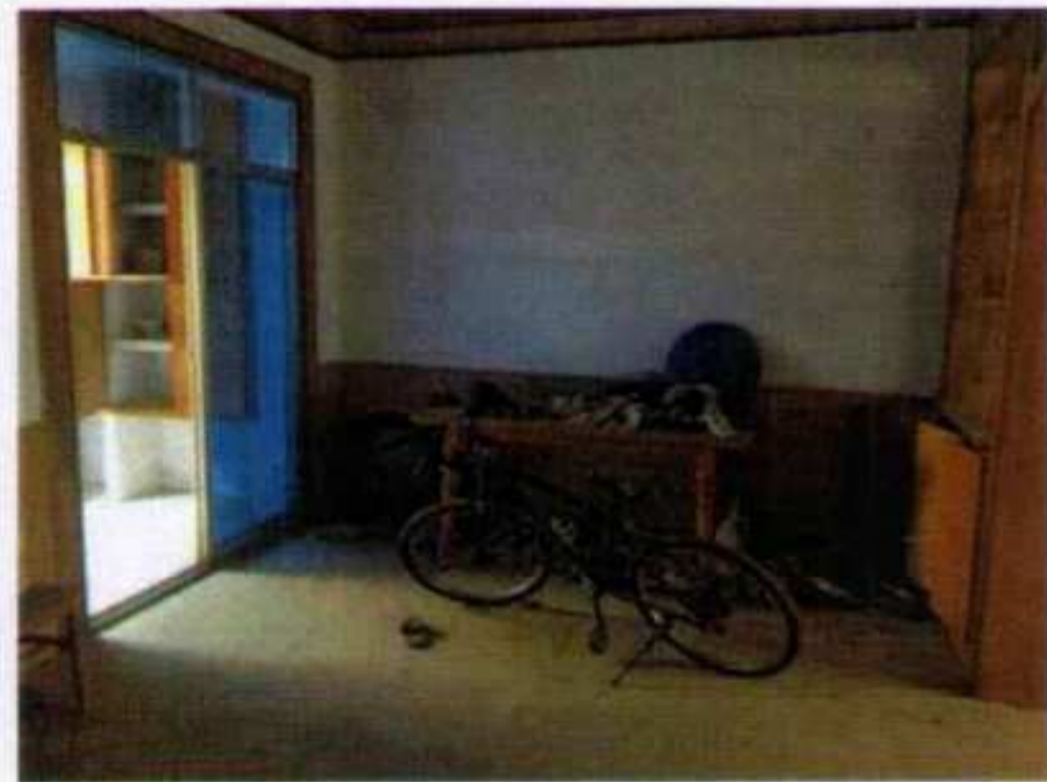
现状照片四：饭厅
