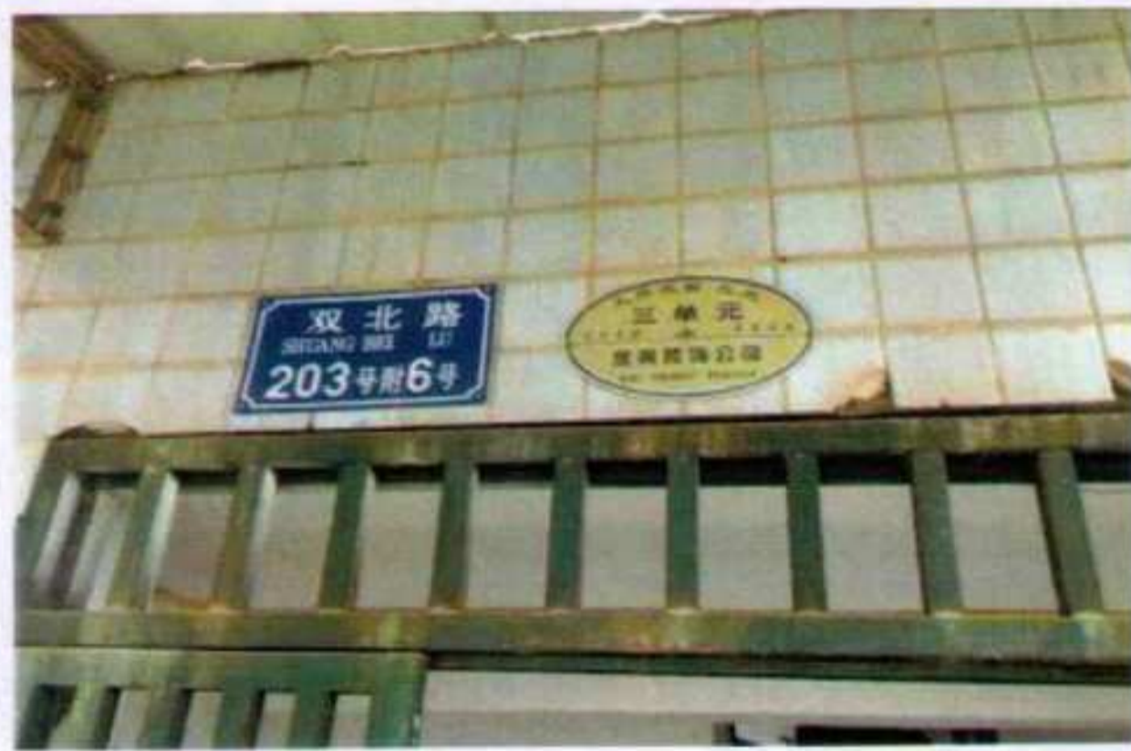
现状照片一：街道号
