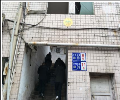
◆ 估价对象幢入口
