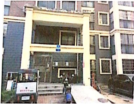
估价对象单元入口
