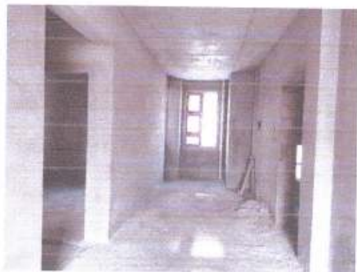
估价对象6号楼—内部
