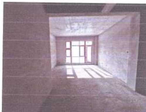
估价对象4号楼—内部
