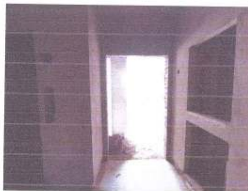
估价对象7号楼—内部
