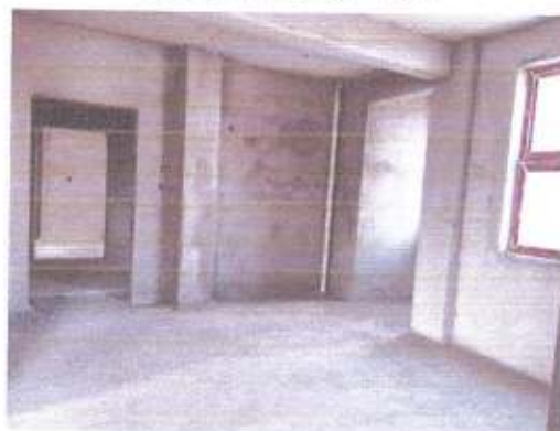
估价对象6号楼—内部
