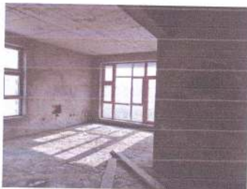
估价对象7号楼—内部
