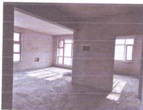
估价对象7号楼—内部
