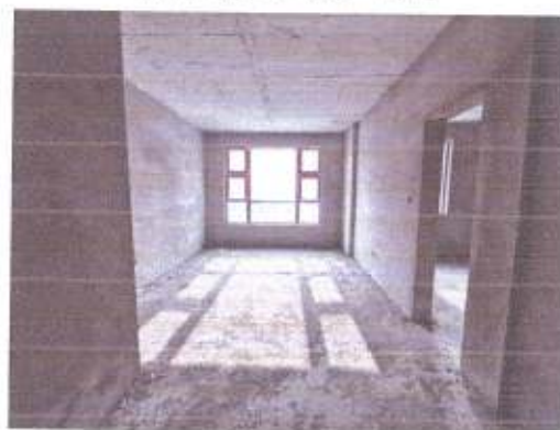
估价对象6号楼—内部
