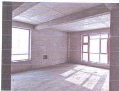
估价对象4号楼—内部
