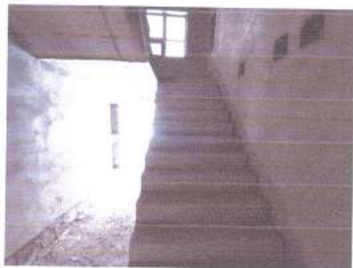
估价对象4号楼—内部
