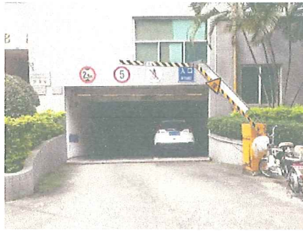
估价对象 1-4 车库入口
