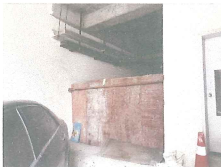
估价对象 5-7 车库出入口
