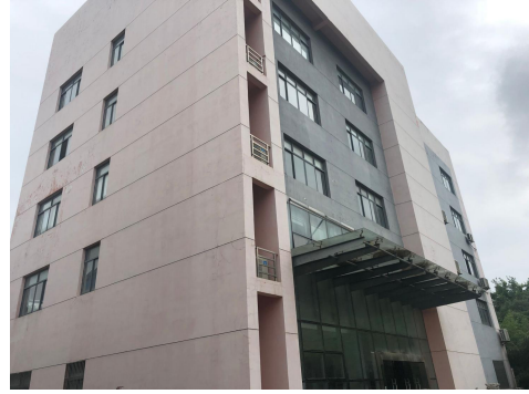
估价对象办公楼外观
