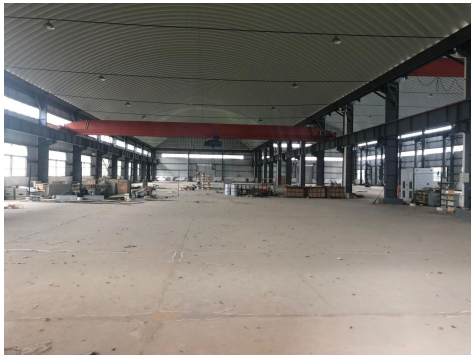
估价对象生产车间内部现状
