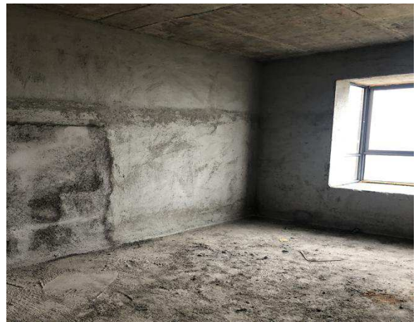
估价对象内部状况
