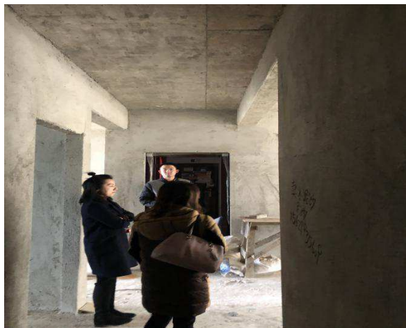
估价对象内部状况
