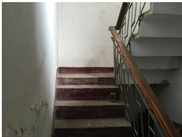
估价对象楼梯
