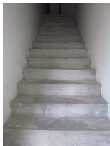
估价对象所在建筑物楼梯
