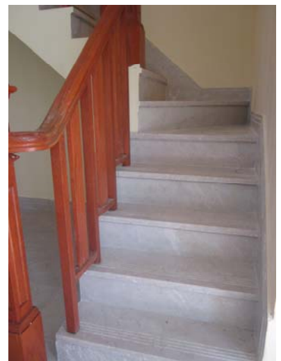
估价对象内部楼梯
