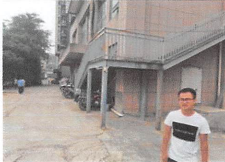
现状照片二：估价对象外立面
