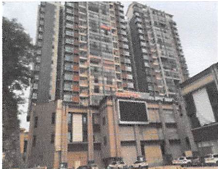
现状照片三：估价对象外立面
