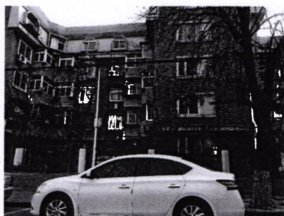
可比实例2楼整体
