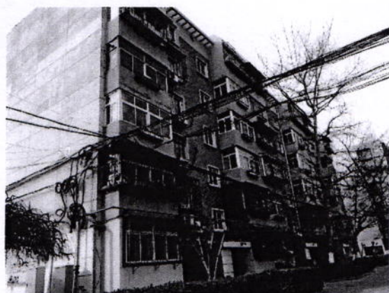
可比实例1楼整体
