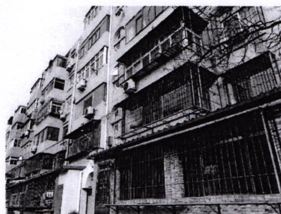
可比实例3楼整体
