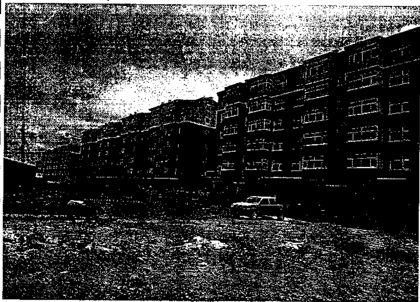
2 盛华苑小区4#楼住宅 1-201
