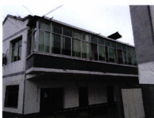
照片说明：余庆县黔龙民族药业有限责任公司名下位于余庆县龙溪镇跳蹬河房产成套住宅现状
