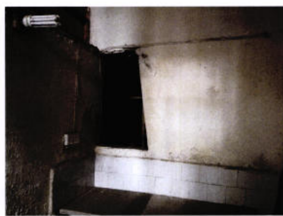
照片说明：杨家林名下位于余庆县龙溪镇西街房地产-加工房、仓库现状
