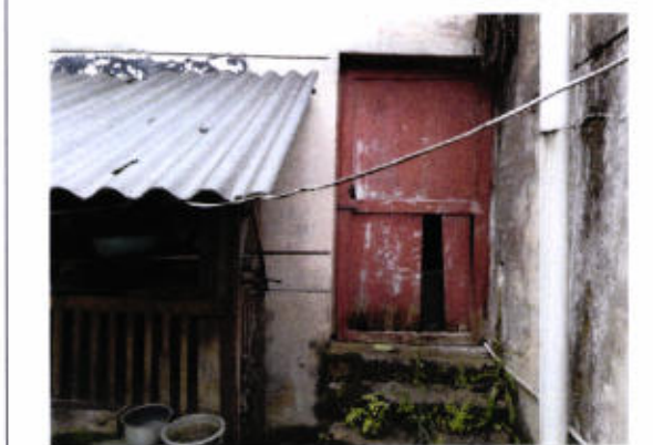
照片说明：杨家林名下位于余庆县龙溪镇西街房地产-加工房、仓库现状
