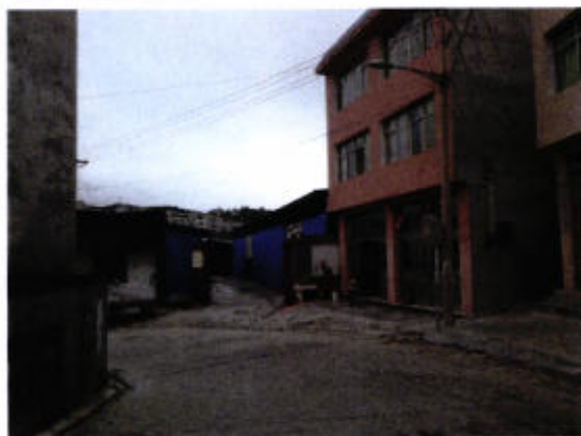
照片说明：余庆县黔龙民族药业有限责任公司名下位于余庆县龙溪镇跳蹬河房产所在道路环境现状
