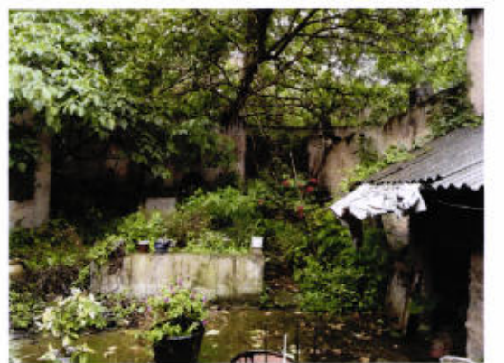
照片说明：杨家林名下位于余庆县龙溪镇西街房地产-加工房、仓库现状
