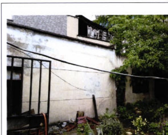
照片说明：杨家林名下位于余庆县龙溪镇西街房地产-加工房、仓库现状
