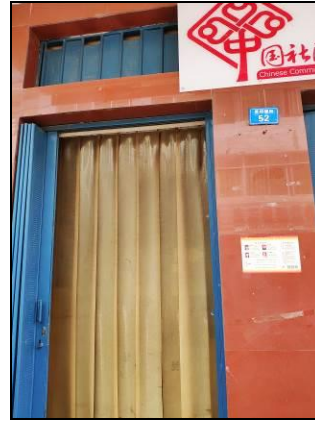
估价对象房屋门牌号状况
