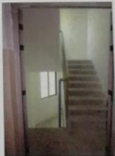
估价对象所在建筑物楼梯
