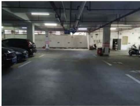
车库内部状况
