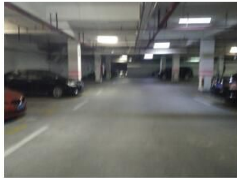
车库内部状况
