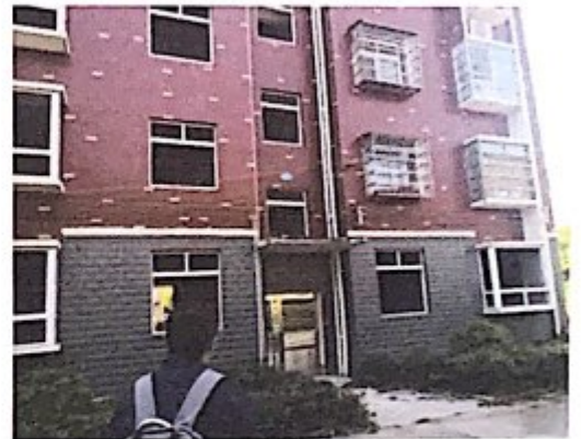
4号楼1单元入口
