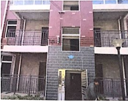
4号楼2单元入口
