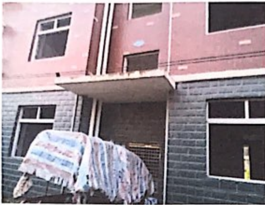
5号楼2单元入口
