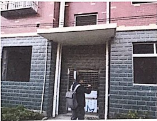
5号楼3单元入口
