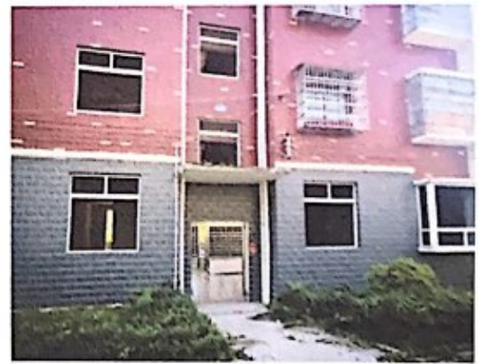
4号楼3单元入口
