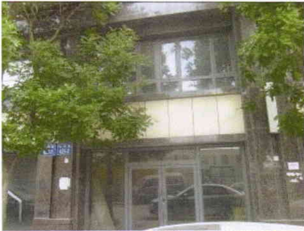
现场查勘照片
