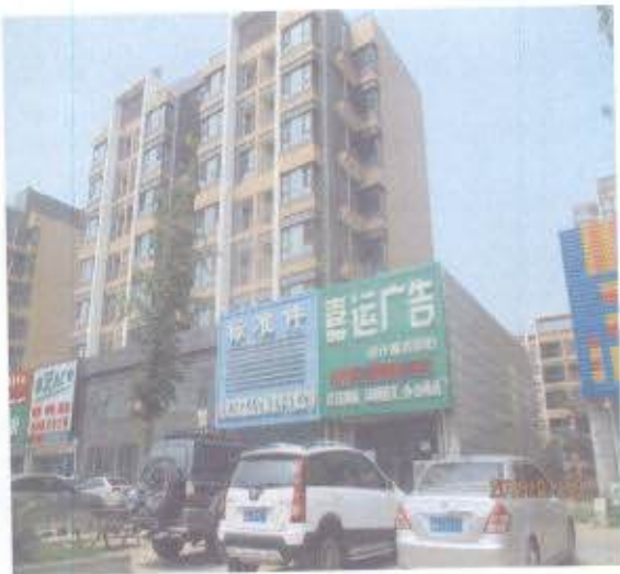
估价对象所在楼外景
