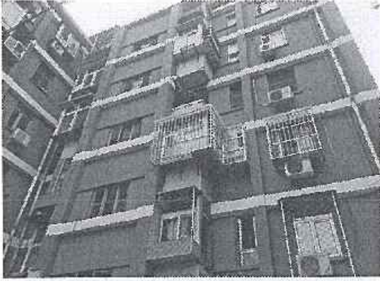
估价对象楼宇外观
