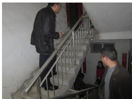
估价对象楼梯间
