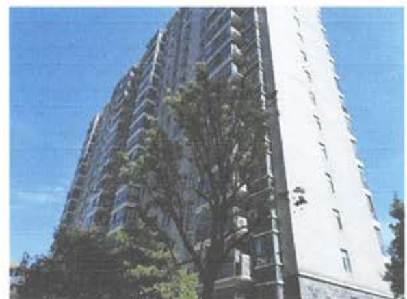
估价对象大楼外观
