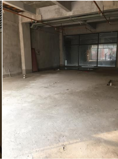
1 层临街商铺内部
