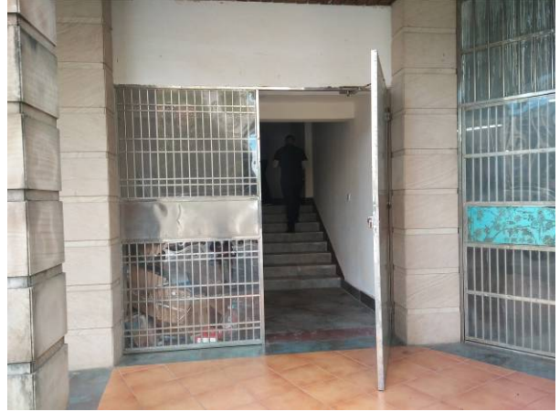
估价对象单元入口
