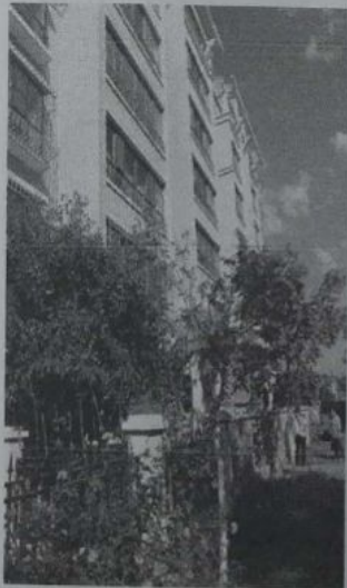
建筑物外观状况
