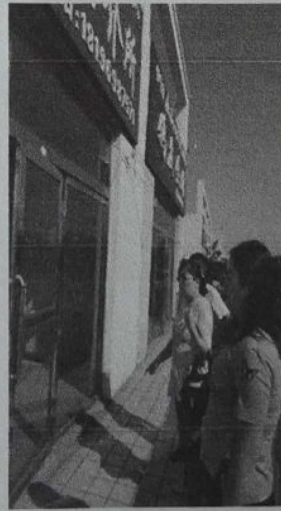
建筑物外观状况
