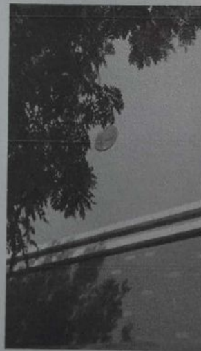
建筑物外观状况
