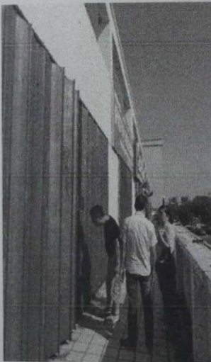
建筑物外观状况
