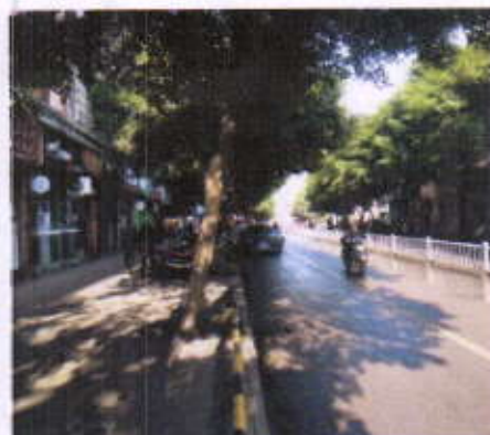
估价对象临街状况
