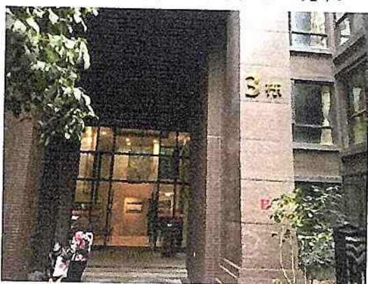
估价对象单元入口现状
