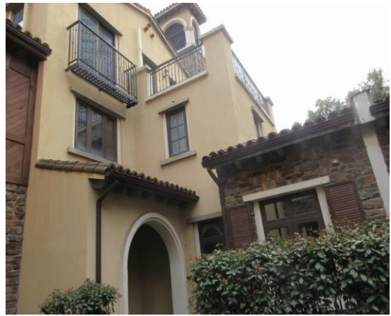
估价对象侧外立面
