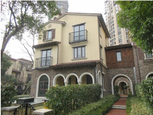
估价对象正外立面
