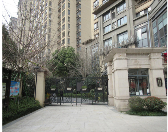
小区南门入口
