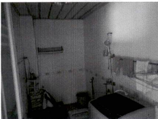
估价对象内部状况
