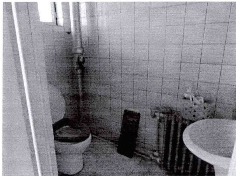
估价对象内部照片
