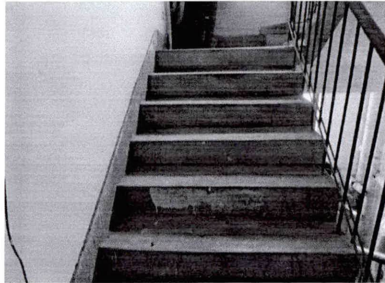
估价对象楼梯图片
