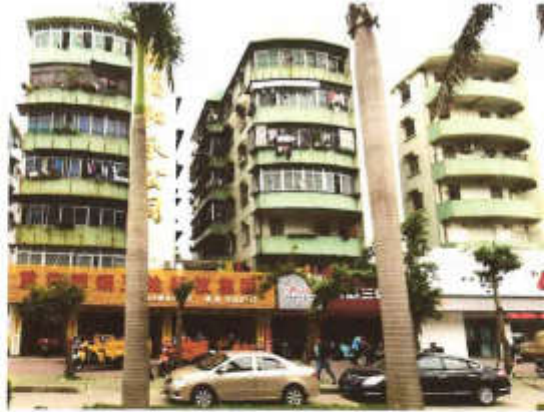
估价对象楼体外观状况
