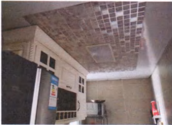
估价对象现状照片
