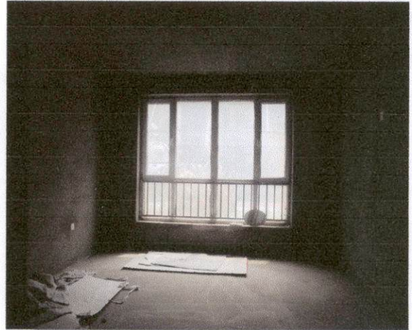
估价对象 (2) 内景 (A14#楼)
