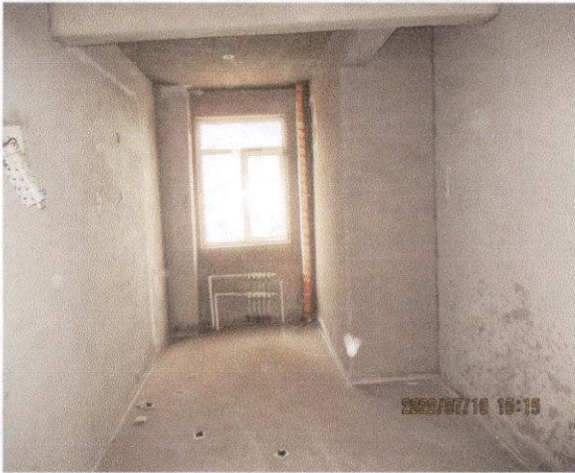
估价对象 (99) 内景 (A4#楼)
