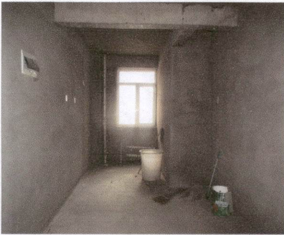
估价对象 (2) 内景 (A14#楼)
