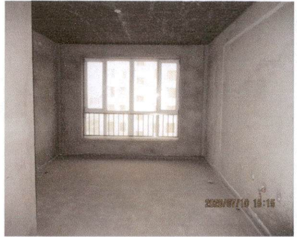
估价对象 (99) 内景 (A4#楼)
