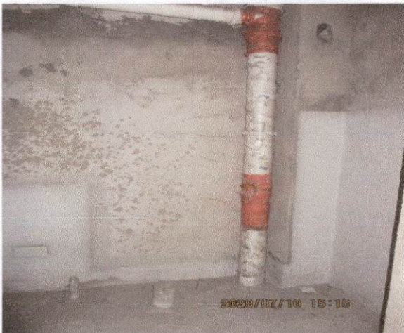
估价对象 (99) 内景 (A4#楼)
