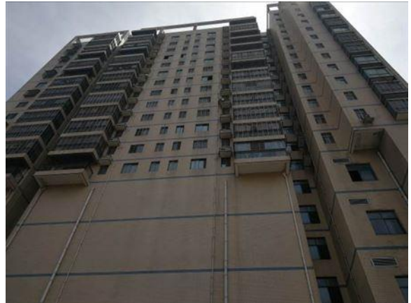
楼栋外观（背立面）
