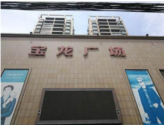
楼栋外观（正立面）
