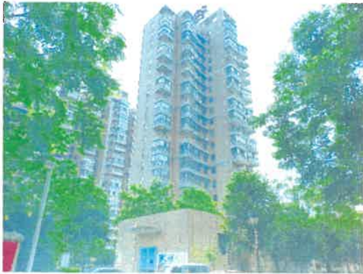
房屋建筑物外部状况
