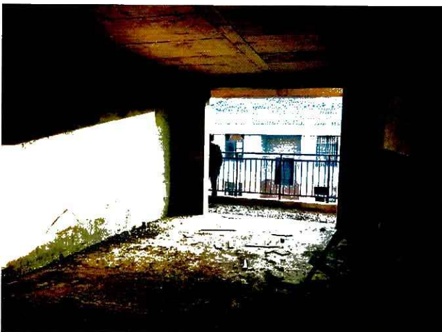
2 栋一单元 602 室内部
