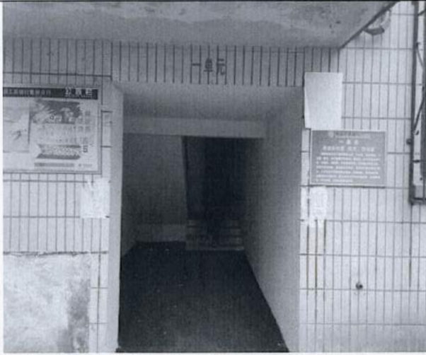
估价对象楼栋入口
