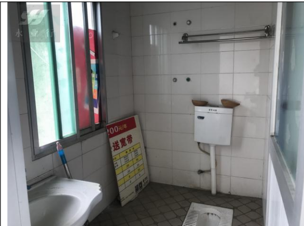
估价对象卫生间概貌
