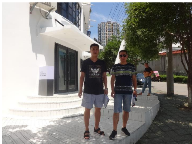
商铺入口（估价师实地查勘照片）
