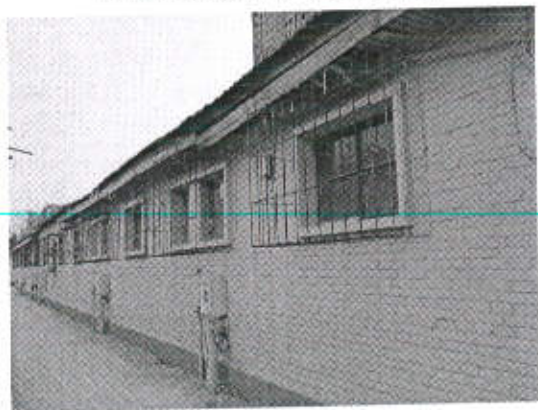
矿院平房 6 排 5 号瓦房北侧
