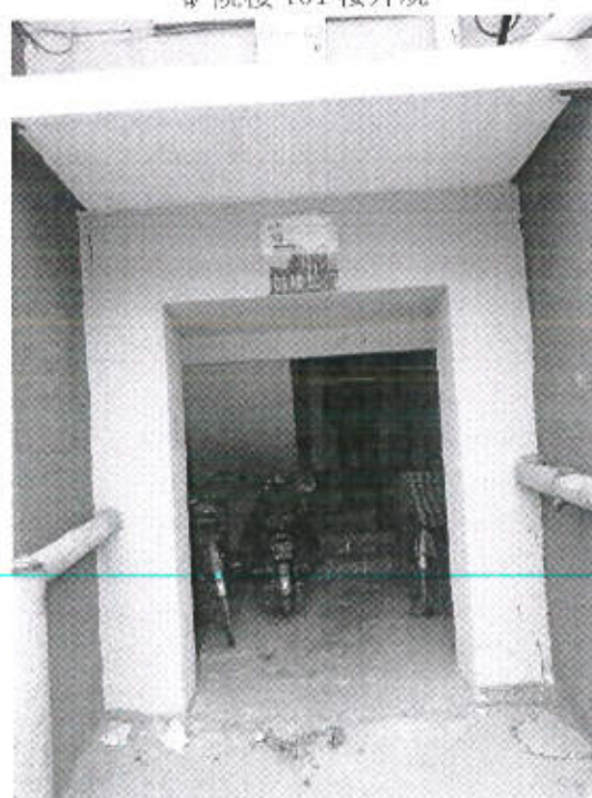
矿院楼 101 楼 2 单元门口
