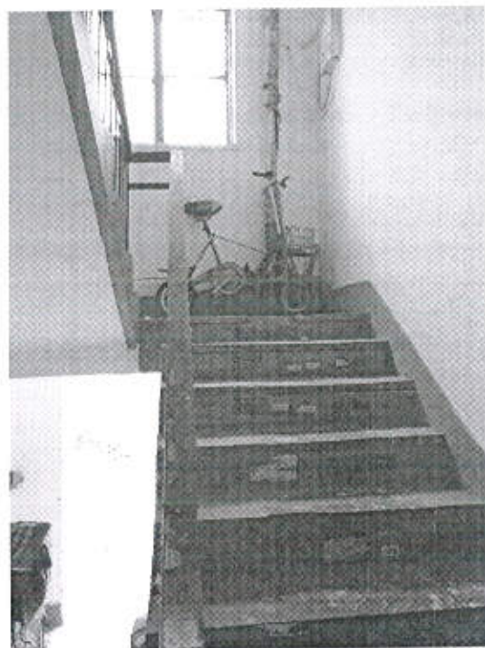
矿院楼 101 楼 2 单元楼梯
