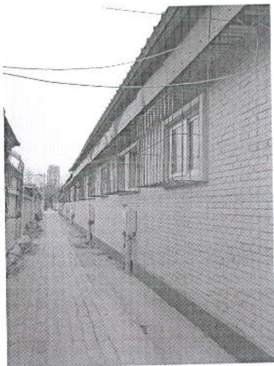
矿院平房 6 排 5 号瓦房北侧
