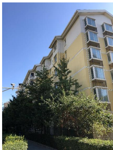
所在项目楼外观
