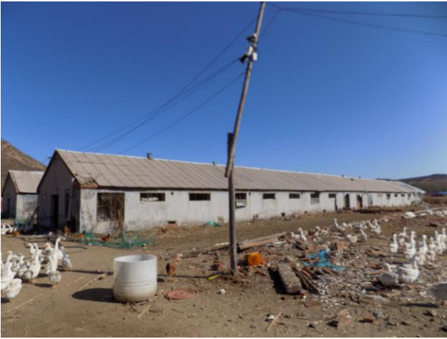
村房字第柒拾号外观照片
