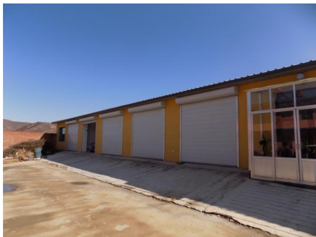
原村房字第 56 号外观照片
