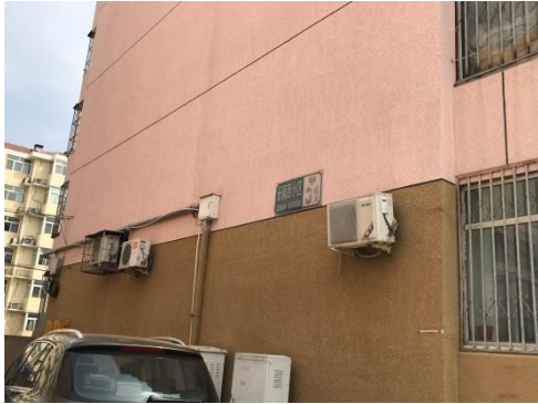
所在项目楼外观
