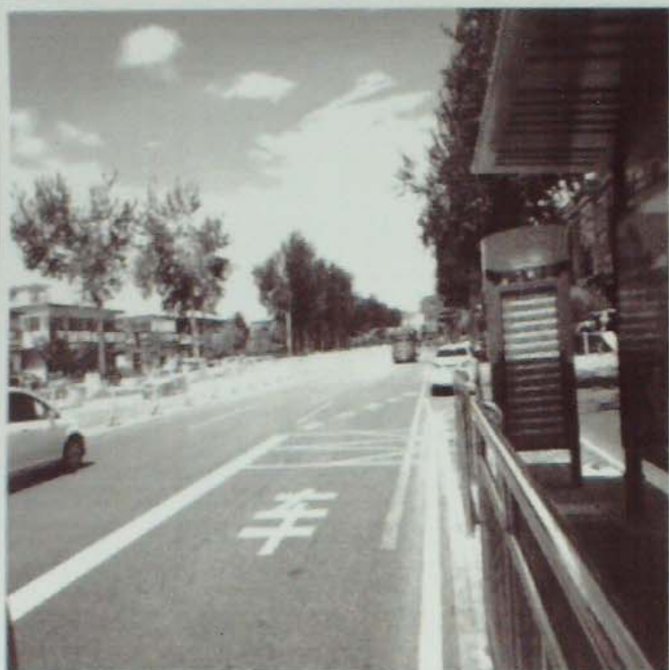
乐园西小区西侧谷丰路
